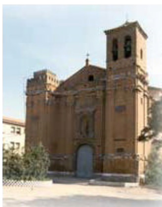
La fachada de la iglesia (1985)
